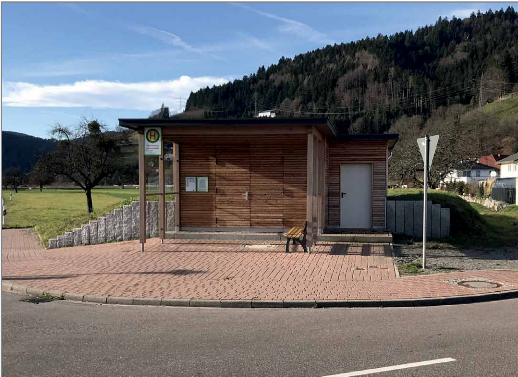
Arnold Schmid : Die Technikzentrale mit Eisspeicher als Bushaltestelle in Fischerbach
