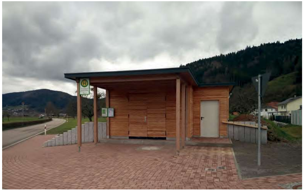
▲ Die Technikzentrale als Bushaltestelle in Fischerbach
