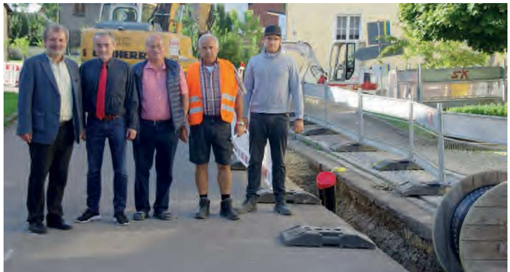
▲ Projektbeteiligte und Baufirma (v.l.): 1. Bürgermeister Andreas Birzer, BEG-Vorstand Dr. Bernd Weber, 3. Bürgermeister Werner Schmelz, Karl Schad und Florian Schad (Tiefbau)
