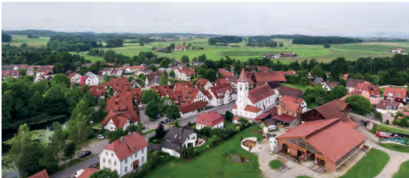
▲ Die Gemeinde Schlier in Baden-Württemberg zeigt in der Praxis, wie ein neues Wohnbaugelbiet möglichst klimaneutral und zugleich kostengünstig mit Strom, Wärme und Mobilität versorgt werden kann.
