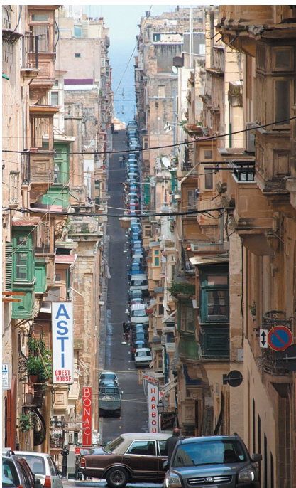
„Die Strassen von San Francisco??“ – Nein, ein Straßenzug in der Hauptstadt Valletta
