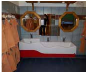
Wir bekommen Hilfe von der Gemeinde zur Installation neuer Waschbecken mit sensorgesteuerten Hähnen.
