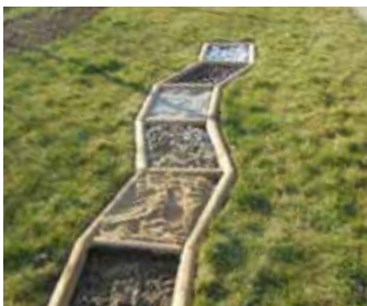
Bau eines Tastweges mit Naturmaterialien
