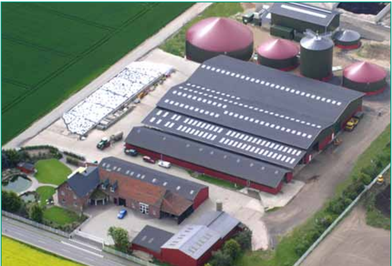
Biogas und Photovoltaik, eine ideale Kombination für den Landwirt, der auch Energiewirt sein will. Biogas- und Photovoltaik Anlagen auf dem von Meerschen Hof in Euskirchen-Palmersheim. Foto: von Meer
