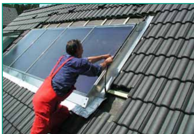
Anlagenmechaniker bei der Arbeit Foto: energie bau köln
